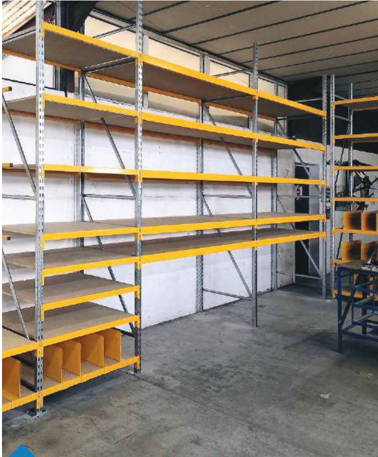
Hyllyjärjestelmä asennettuna kilpapyörien kokoonpanotyöpajaan.
