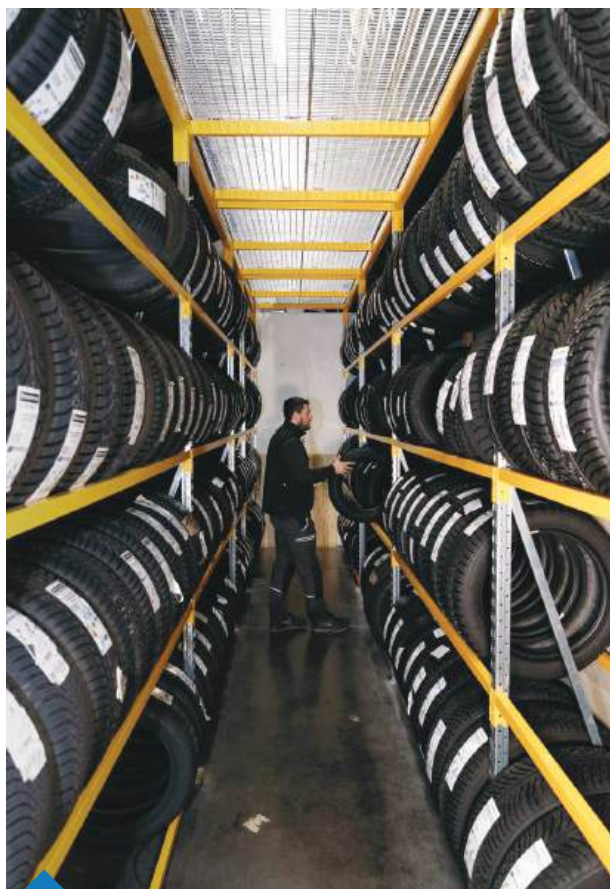
Käytävän kansirakenne on kiinnitetty runkorakenteisiin.
