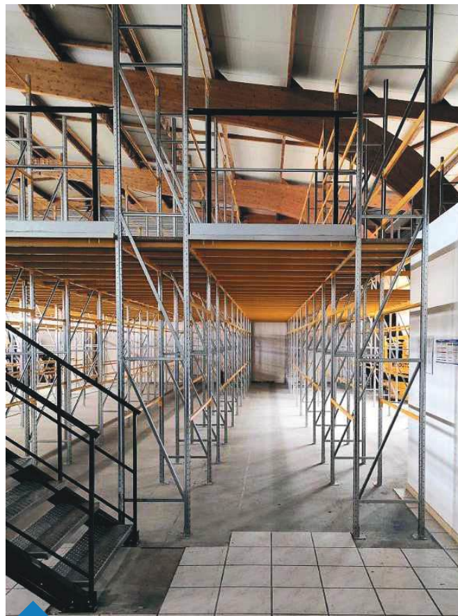
Kulkuteillä varustettu taso ovaalipalkeilla verkkokirjputorin varastoon.
