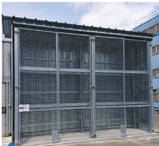
Verhouksella ja verkko-ovilla suojattu kokonaisuus.
