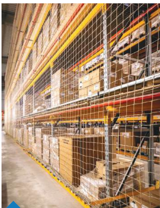
Kävelytaso varmistettu putoamissuojaverkolla ja lavapysäyttimillä.
