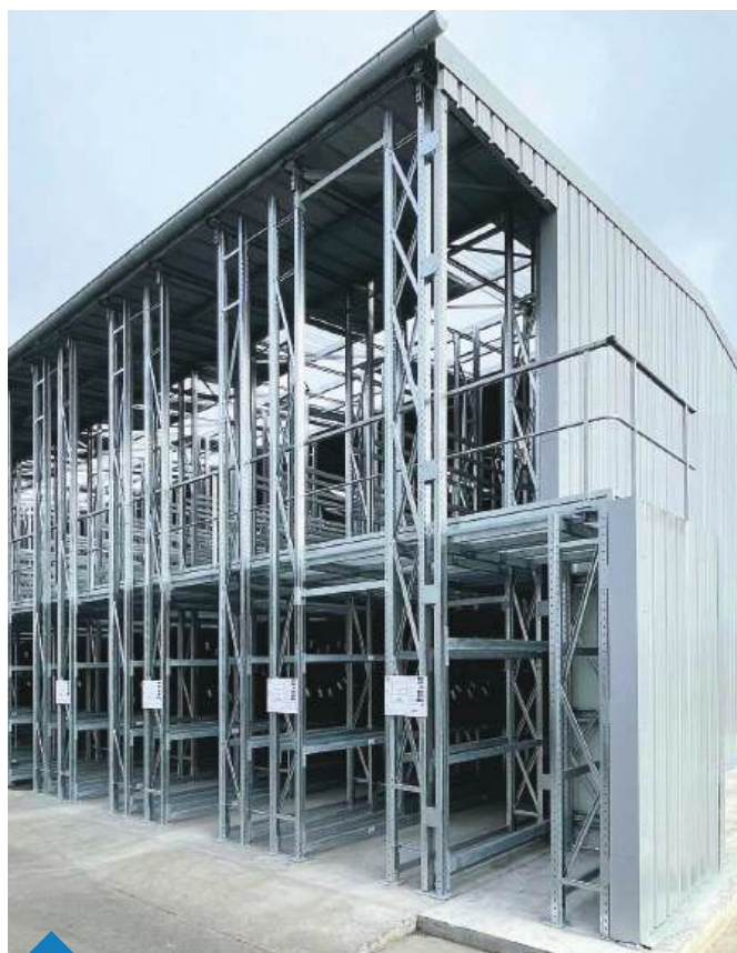
Itsekantava rakennus: tasorakenne käveläväylään PROPAL 3 -hyllystön rungon varassa.
